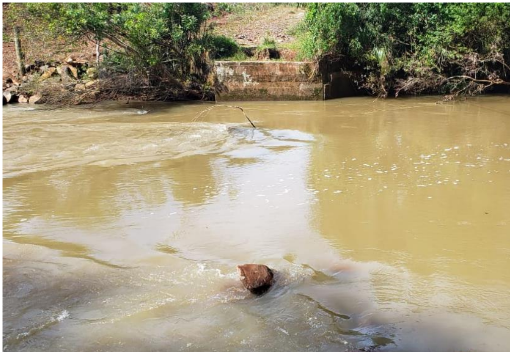
Figura 02: Cabeceira atual que será removida – Lado Campos Novos - SC
