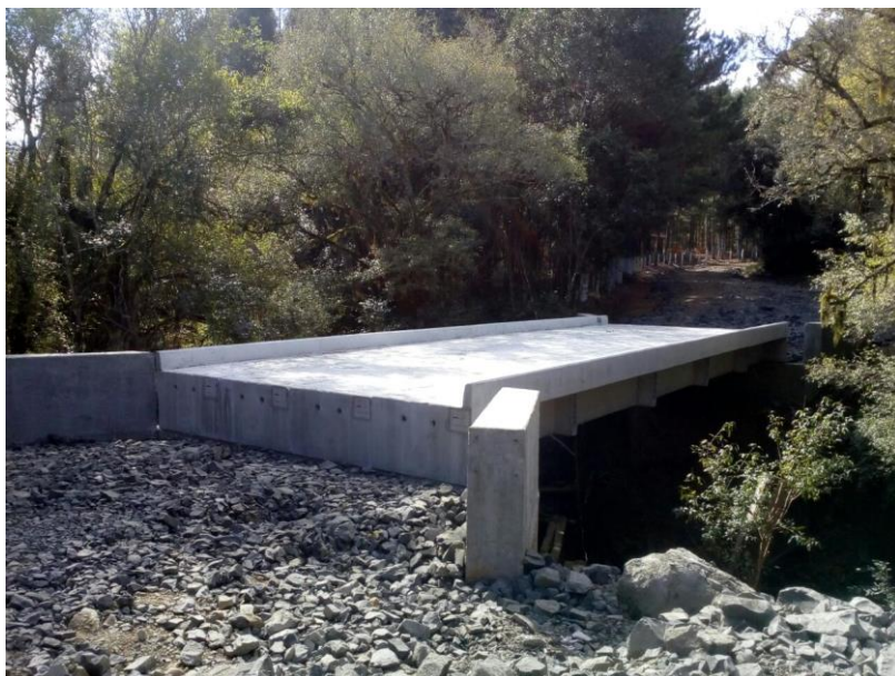
Figura 5 – Modelo ilustrativo de ponte com tabuleiro pré-moldado.
