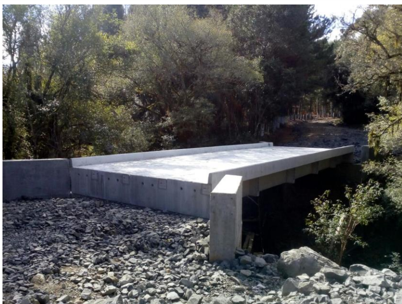
Figura 5 – Modelo ilustrativo de ponte com tabuleiro pré-moldado.
