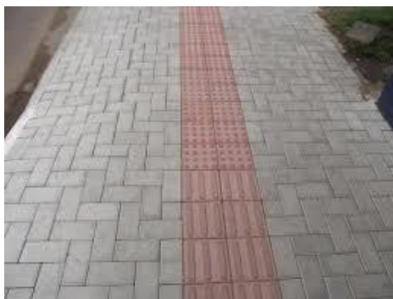
Aplicação Piso Tátil Direcional e Alerta no Passeio com Paver
